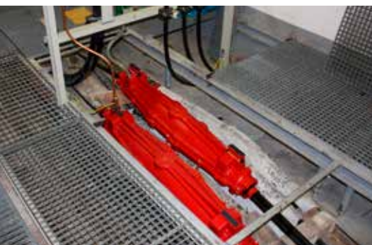
Öl-Nachfüllmuffen in Schaltanlage
